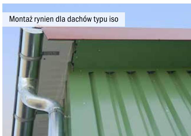
Montaż rynien dla konstrukcji dachu t.z. zimnego
